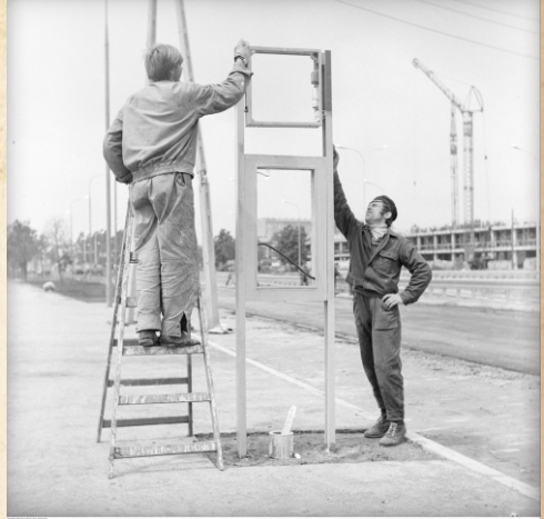
fol. Narodowe Archiwum Cyfrowe, sygn. 3/40/O/6/20 (daw. 40-5-20); Montowanie podświetlanej tablicy na przystanku autobusowym zbalizowanym na Trasie Łazienkowskiej; lipiec 1974
